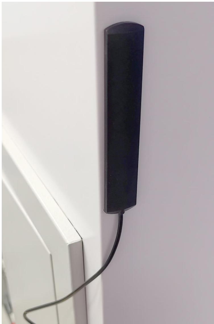
Рисунок 2 – Пример установки антенны на самоклеющемся основании, пластиковый шкаф с врезной металлической панелью учета
