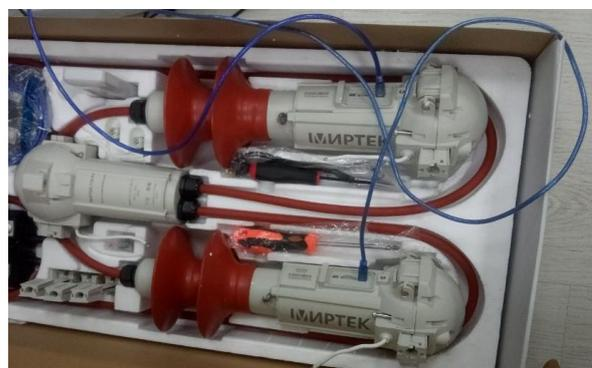
Рисунок 1.2в – Подключение питания к ВПУ с 2-мя измерительными блоками при наличии модулей связи в обоих блоках.
