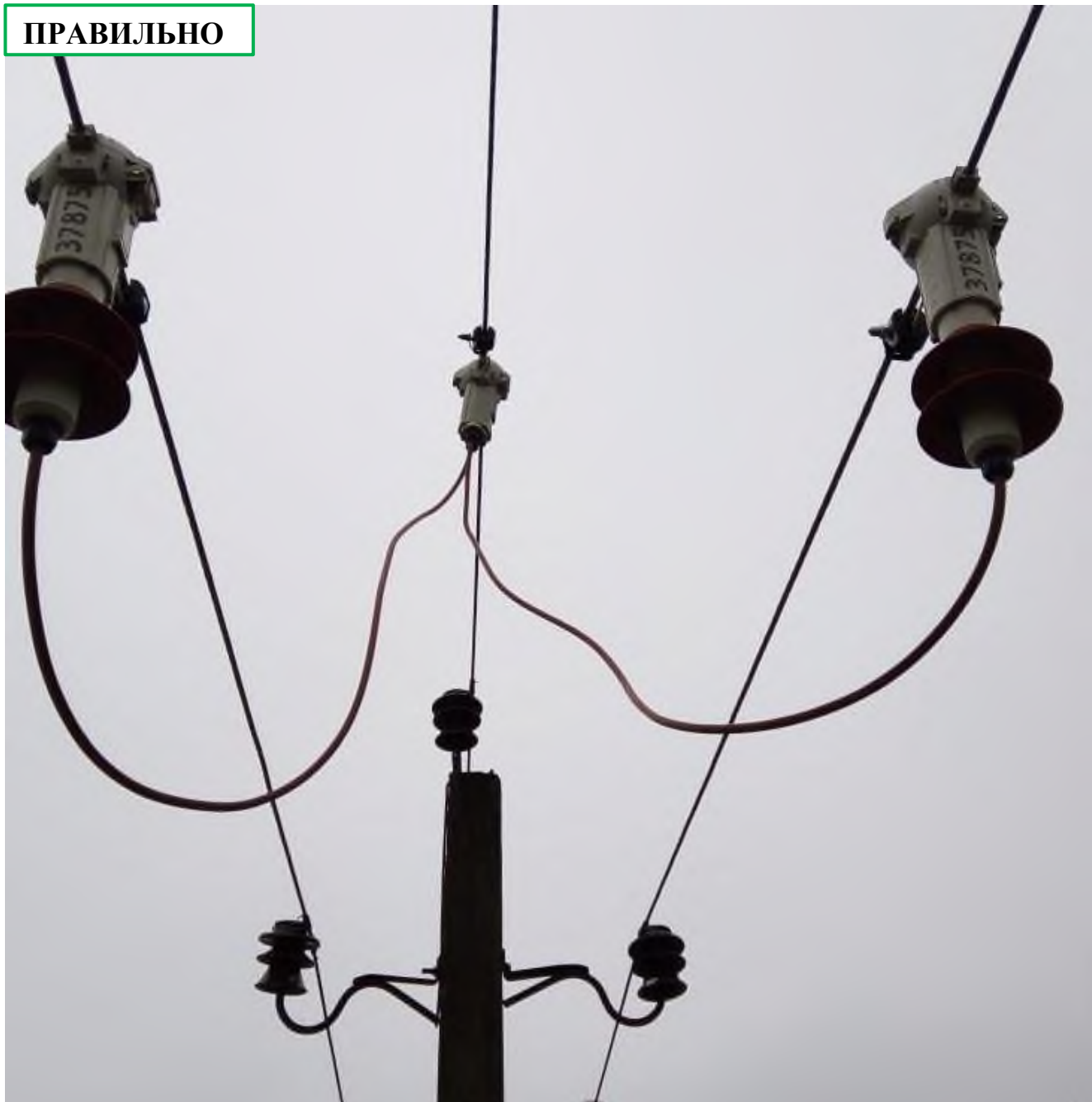
Рис. 17 – Правильное расположение кабелей ВПУ на линии ВЛ
